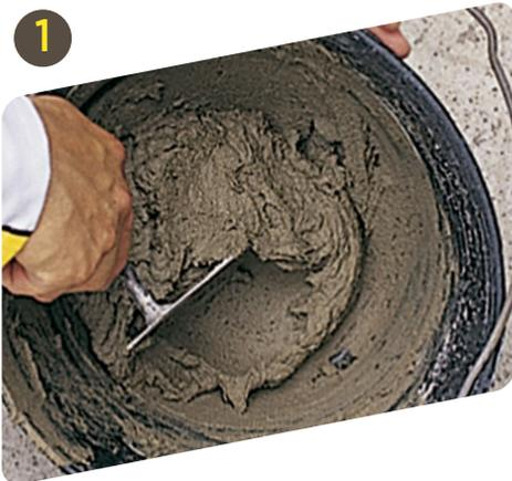
Colocar agua limpia en el balde (1 lt de agua limpia cada 5 kg), luego incorporar **weber refractarios** y mezclar manual o mecánicamente hasta obtener una pasta homogénea.
