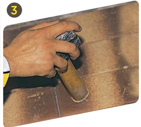
Colocar las piezas refractarias, presionar y nivelar la superficie. Empastinar con el mismo material 48 hs posteriores a la colocación y 48 hs después se sugiere dar fuego para mejorar el endurecimiento. Proteger de las lluvias hasta tanto no haya endurecido.
