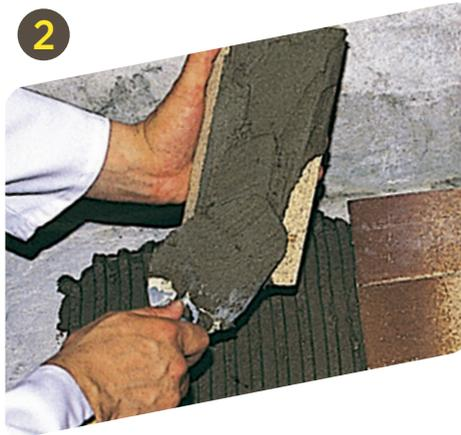
Dejar reposar 5 minutos, remezclar y extender sobre el soporte y sobre el revestimiento a colocar. Se debe regularizar el espesor con una llana de 12 mm.
