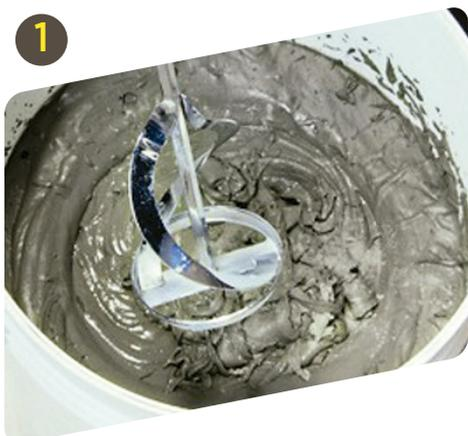
1 Colocar agua limpia en el balde, luego agregar **weber estándar cerámicos** paulatinamente (5 litros por bolsa aprox.). Mezclar manualmente o con batidor eléctrico (500 rpm) hasta obtener una pasta homogénea.
