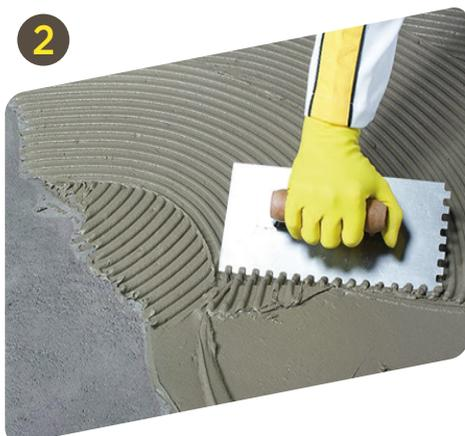
2 Extender sobre el soporte en paños pequeños de 1 m<sup>2</sup> aprox., peinando con una llana dentada para regularizar el espesor y proceder a la colocación.
