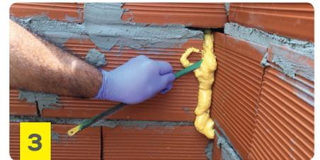
3 Una vez que la espuma se haya endurecido, retirar el exceso con algún elemento cortante: sierra, cuchillo, etc.
