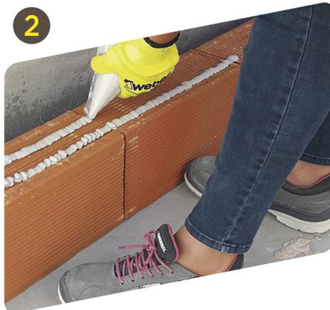
2 Colocar la mezcla dentro de la manga plástica y cortar la punta para poder extruir los cordones. Extrudir dos cordones de 15 mm en la cara horizontal del ladrillo/ bloque y en el caso de los bloques de hormigón celular, también en la vertical.
