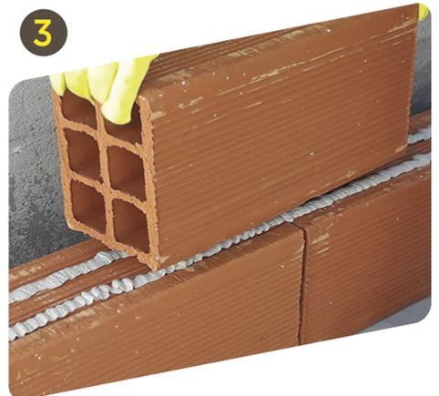
3 Continuar con las hileras regularmente. En el caso de los ladrillos cerámicos, recomendamos utilizar **webermur multiuso** o mortero regular tanto para los refuerzos de hierro, como el asentamiento de la primera hilada. En el caso de los bloques de hormigón celular, se puede usar el mismo producto.
