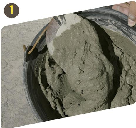
1 Amasar con aproximadamente 4,5/5 litros de agua limpia por bolsa de 25kg, manual o mecánicamente, hasta lograr una pasta homogénea.
